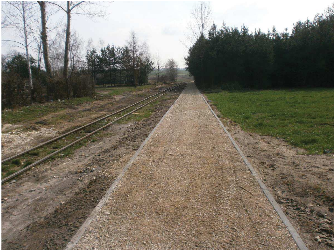
Ilustracja 5. Trasa rowerowa obok linii kolejowej wąskotorowej (zastosowano zły rodzaj nawierzchni)
