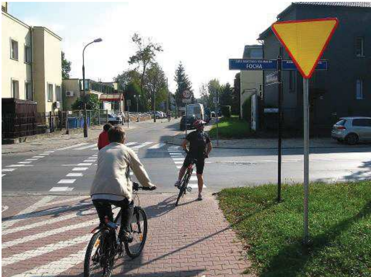
Ilustracja 20. Przykład przejazdu dla rowerzystów zlokalizowanego na końcu drogi dla rowerów (brak znaku C-13a „koniec drogi dla rowerów”)
