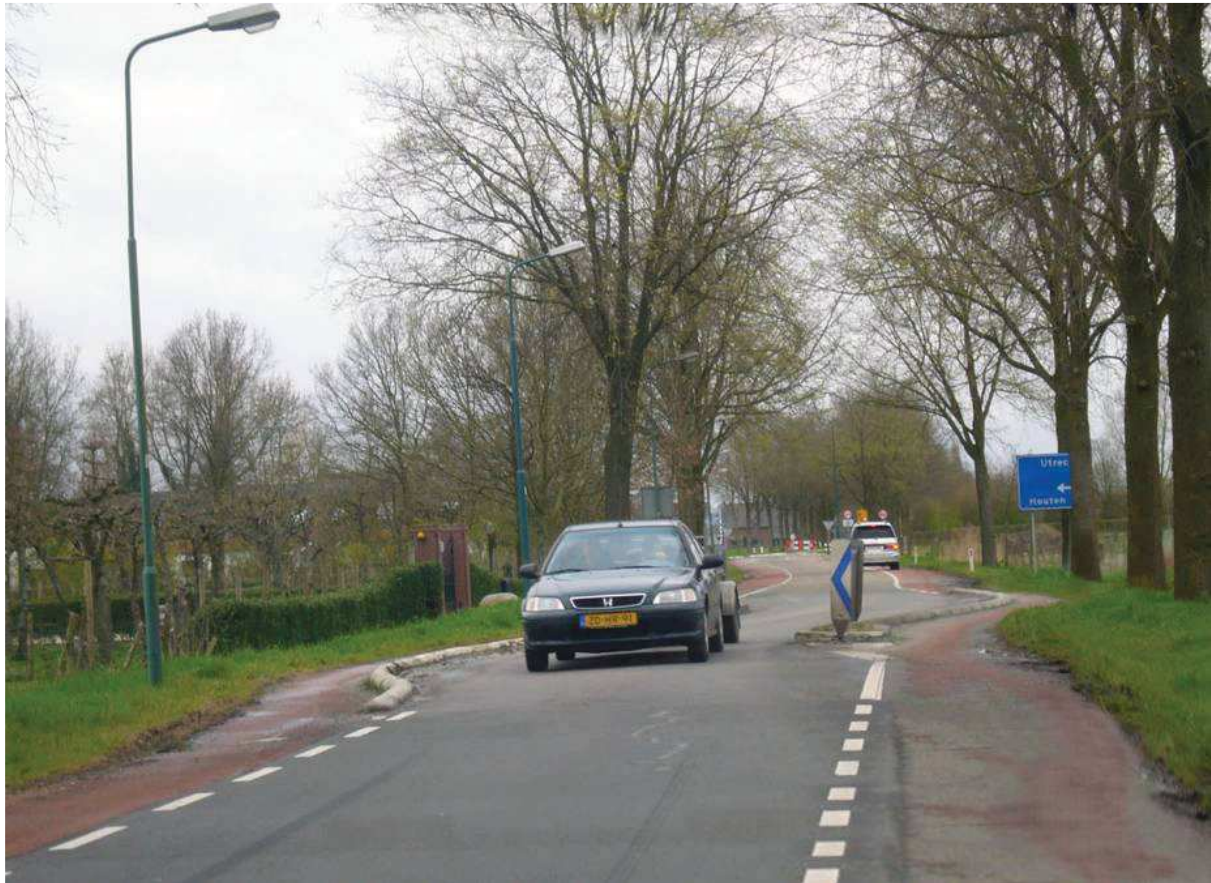
Ilustracja 14. Szykana w postaci dwóch odwrotnych łuków poziomych (odgięcie toru jazdy)
