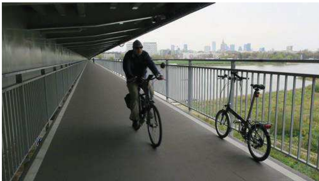
Ilustracja 37. Kładka rowerowa podwieszona pod Mostem Łazienkowskim w Warszawie
