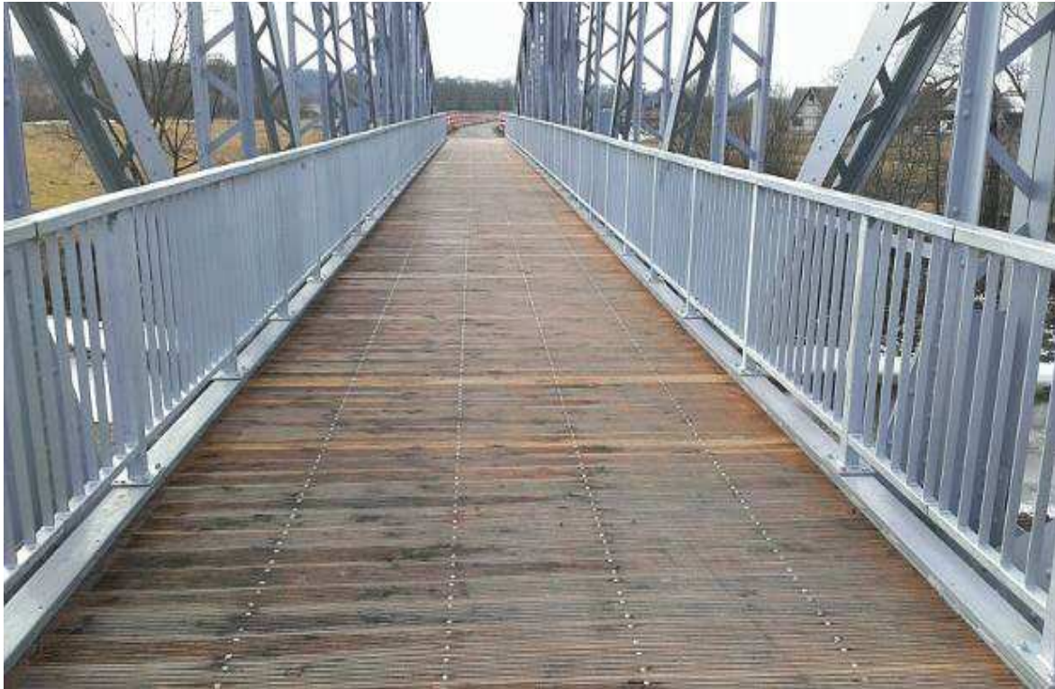
Ilustracja 40. Adaptacja mostu kolejowego na kładkę rowerową
