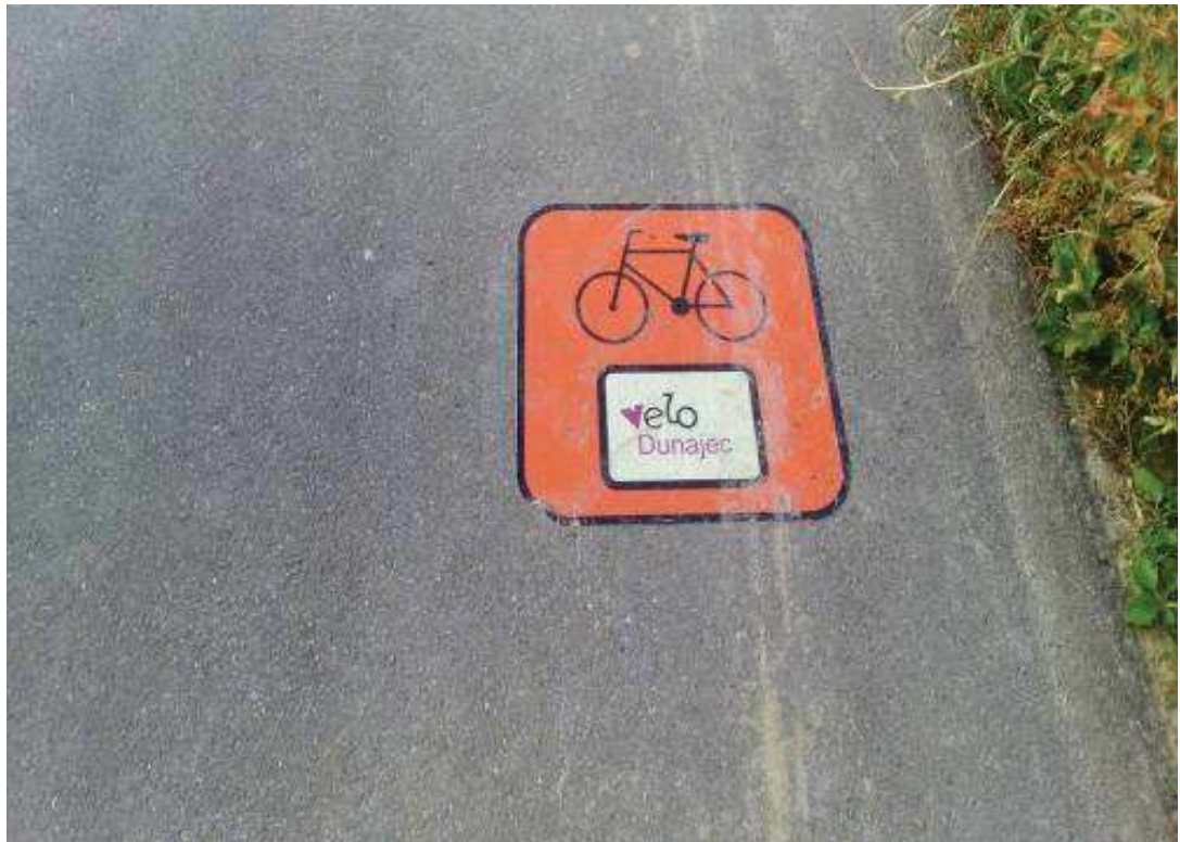
Ilustracja 48. Przykład oznakowania turystycznej trasy rowerowej na nawierzchni
