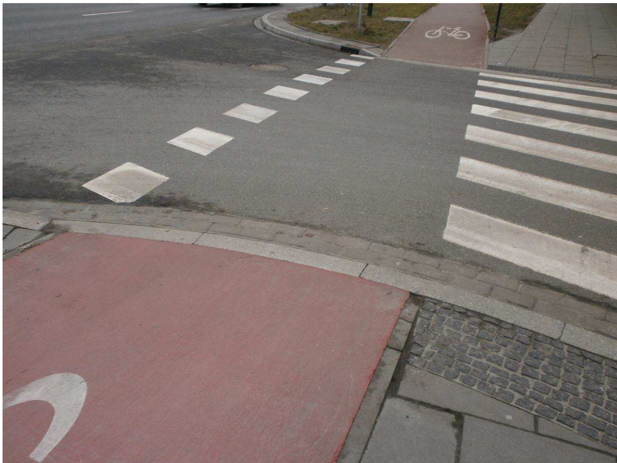
Ilustracja 16. Jednostronne oznakowanie przejazdu dla rowerzystów zlokalizowanego bezpośrednio przy przejściu dla pieszych
