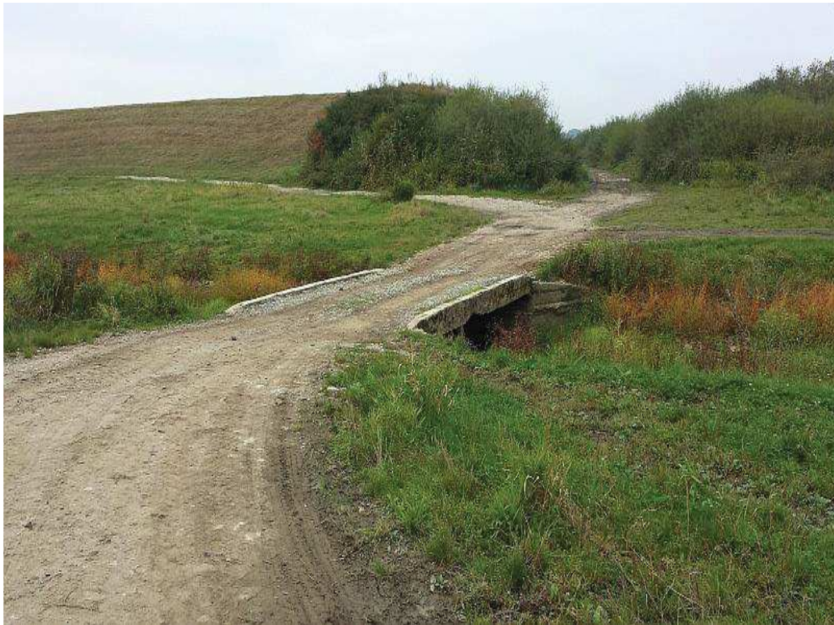
Ilustracja 44. Przykład mostu niskowodnego na ujściu ciek do Wisły
