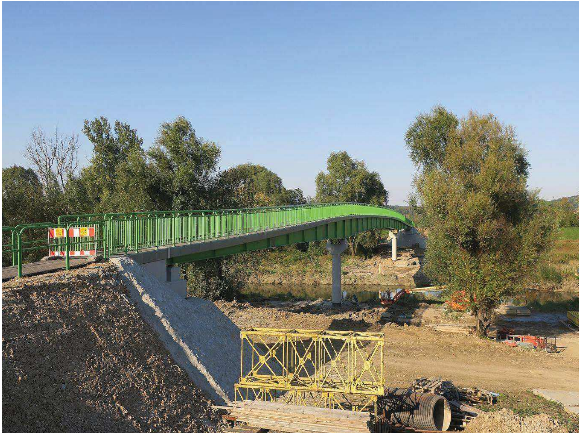
Ilustracja 42. Przykład kładki rowerowej wysokowodnej na ujściu rzeki Skawinki do Wisły
