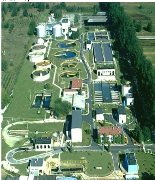
Ryc. 10 Miejska Oczyszczalnia Ścieków w Białej Podlaskiej
